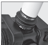
Рис. 10 Монтаж вентиляционного трубопровода
